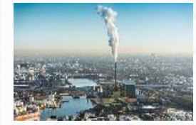
P2F Hemweg 100 MW electrolyser (> 2024)
